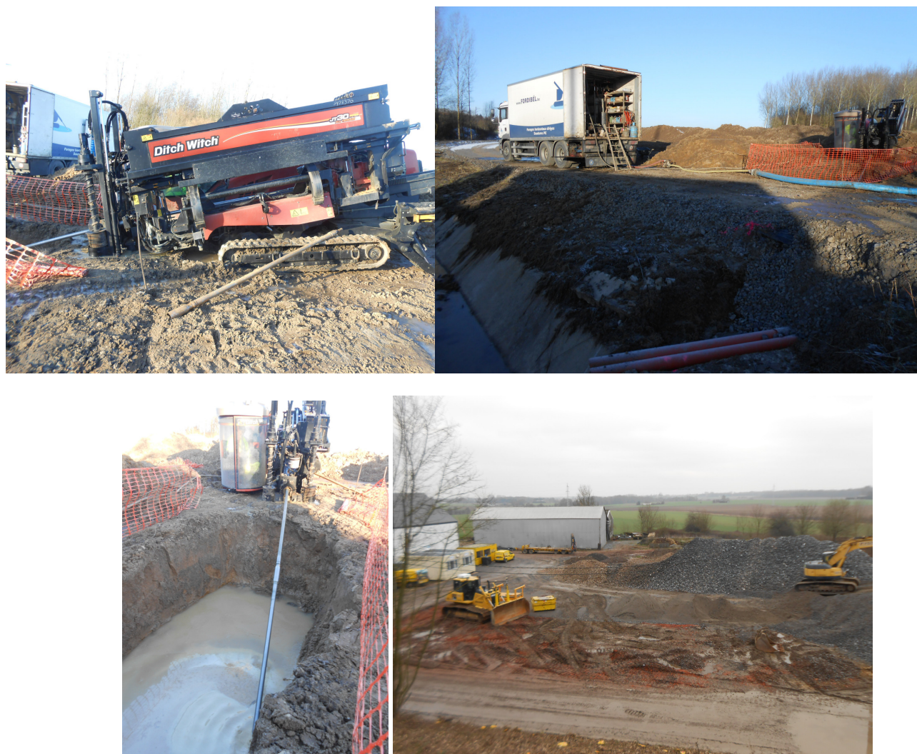
Photos du chantier des éoliennes. Forage pour passer les câbles.
